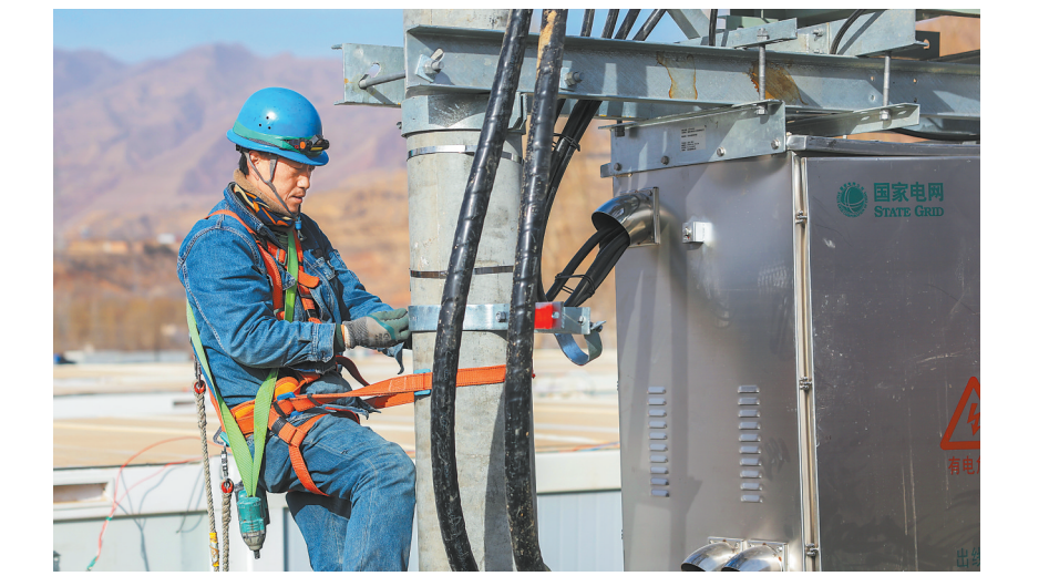
12月28日,在积石山县大河家镇康吊村安置点,国网甘肃省电力公司工作人员正在架设供电线路,全力保障安置点群众正常用电。
