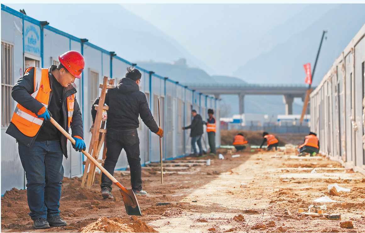
12月28日,在积石山县大河家镇康吊村安置点,施工人员正在平整道路。新甘肃·甘肃日报记者 田蹊 冯乐凯
