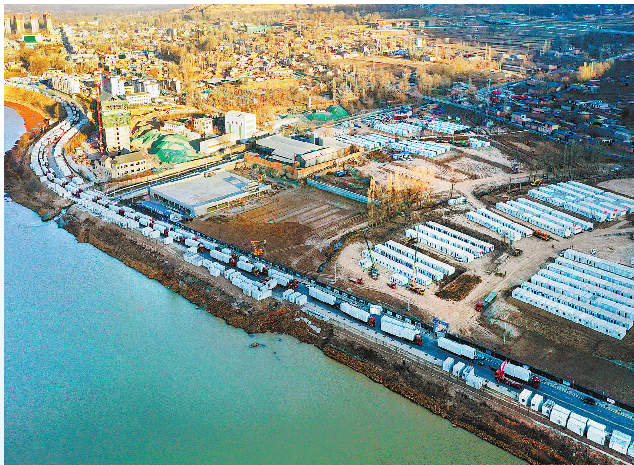
12月26日,刘集乡高李村板房安置点正在加紧施工。
