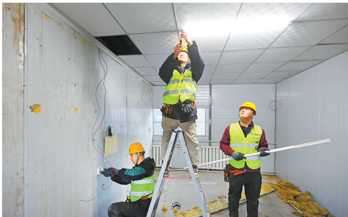
12月26日,甘肃建投六建公司工人在刘集乡高李村抗震救灾安置板房内改造电路。新甘肃·甘肃日报记者 田蹊
