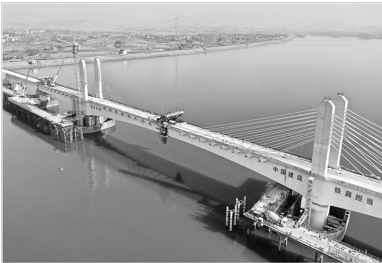
12月26日,浙江省金华市至建德市高速铁路金建铁路首座大跨度矮塔斜拉桥——兰江特大桥顺利合龙,为工程后续架梁施工奠定基础。金建铁路是国家快速铁路网中“黄山至金华”铁路通道的组成部分,设计时速250公里,全长约64公里。新华社发
