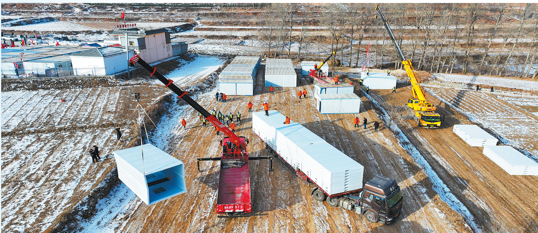
12月21日,工作人员在积石山县大河家镇梅坡村搭建活动板房。新甘肃·甘肃日报记者 丁凯
