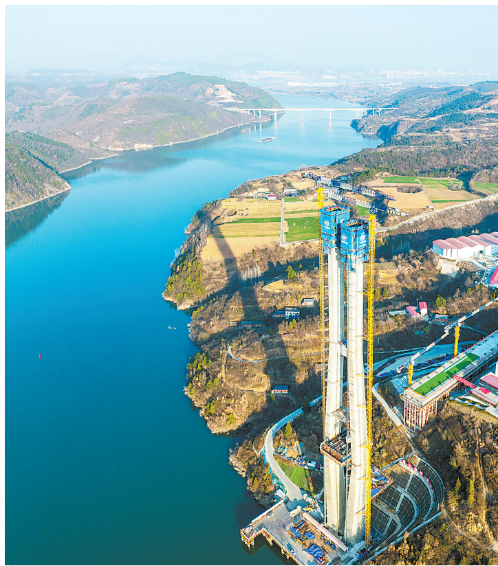
12月24日,位于湖北省十堰市的西(安)十(堰)高铁汉江特大桥P4主塔顺利封顶。图为汉江特大桥P4主塔施工现场。新华社发
