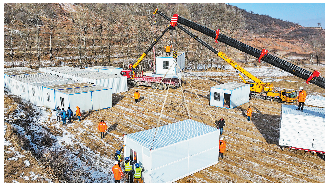
12月21日,积石山县大河家镇梅坡村正在搭建活动板房。
