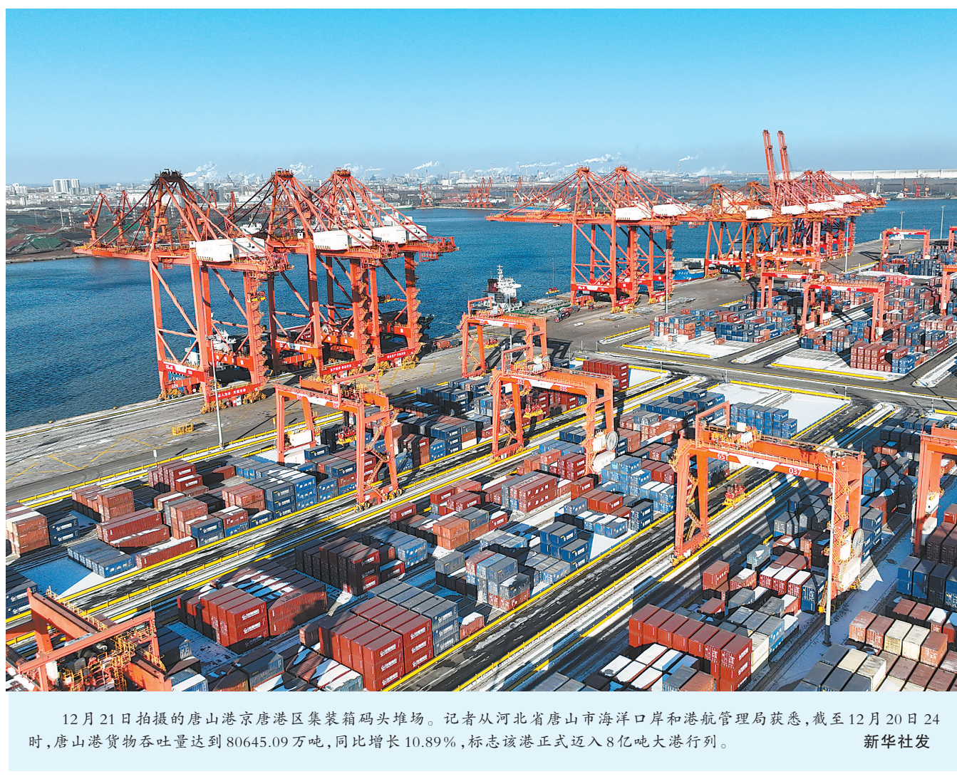
12月21日拍摄的唐山港京唐港区集装箱码头堆场。记者从河北省唐山市海洋口岸和港航管理局获悉,截至12月20日24时,唐山港货物吞吐量达到80645.09万吨,同比增长10.89%,标志该港正式迈入8亿吨大港行列。 新华社发
