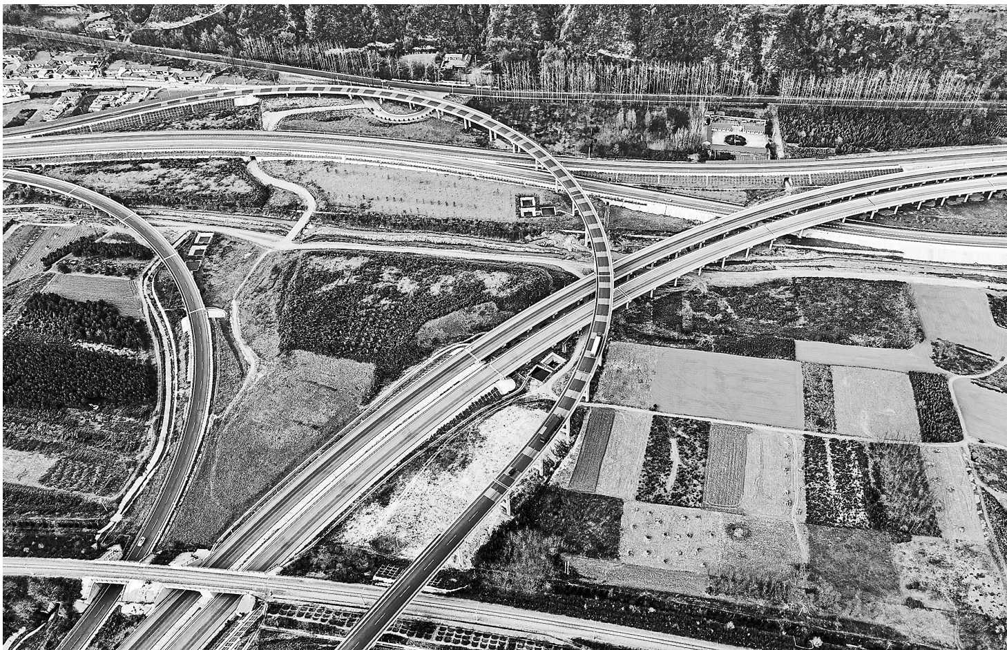
近日,位于华亭市安口镇的G8513(平凉至绵阳)高速公路与G85银川至昆明高速公路相接的枢纽立交桥纵横交错、车流不息。近年来,平凉市已建成东出陕西、西进兰州、南走四川、北通宁夏的高速公路网,有力促进了经济高质量发展。
