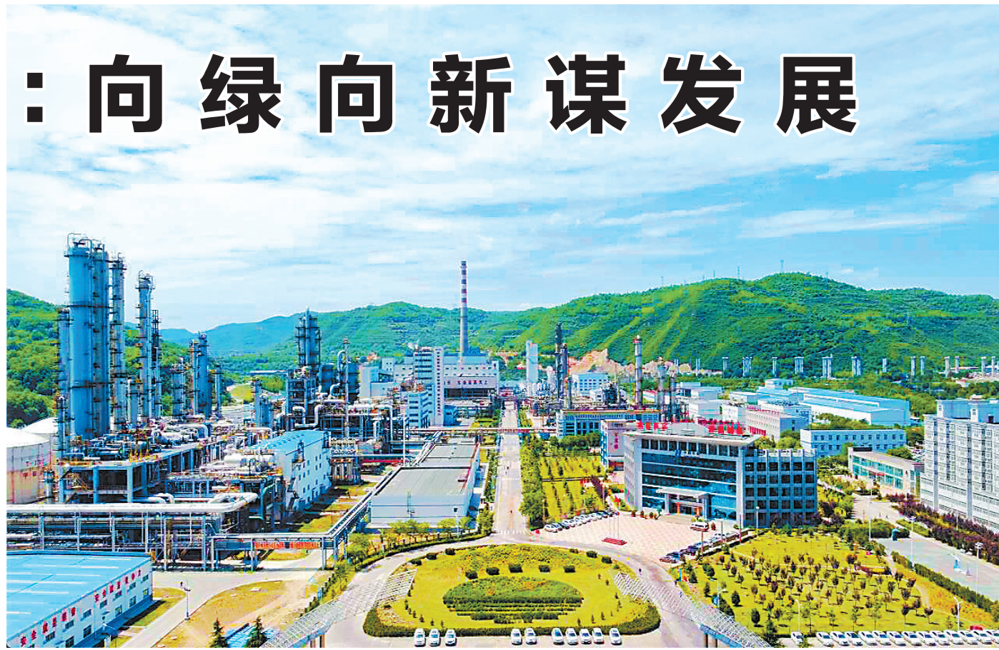
华煤集团煤制甲醇分公司。
