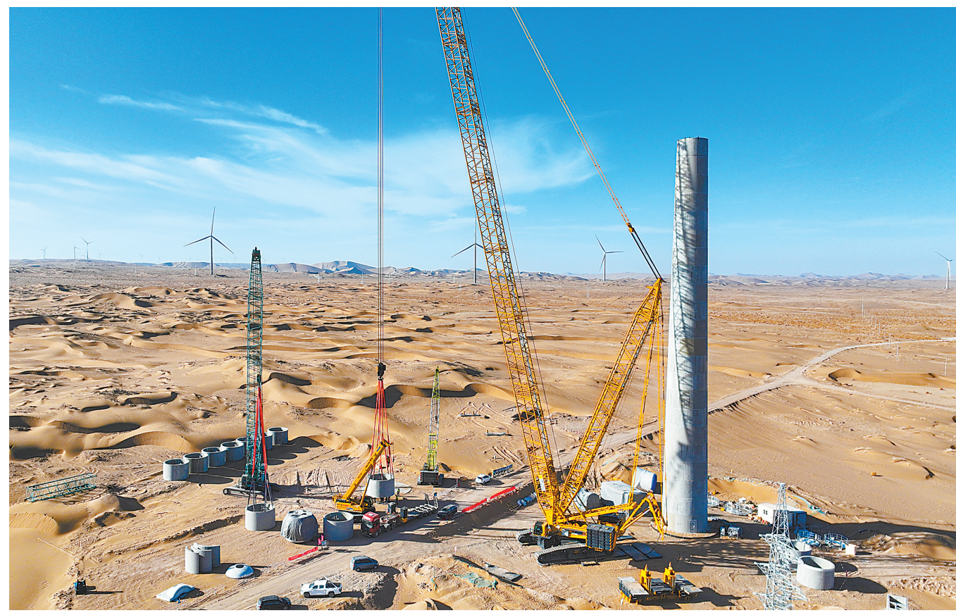
近日,工作人员在上海电气高台北部准百万千瓦风电基地20万千瓦风电2号项目施工现场作业。近年来,高台县着力培育壮大综合能源产业链,引进上海电气等新能源制造龙头企业,建成新能源装备制造产业链基地。
