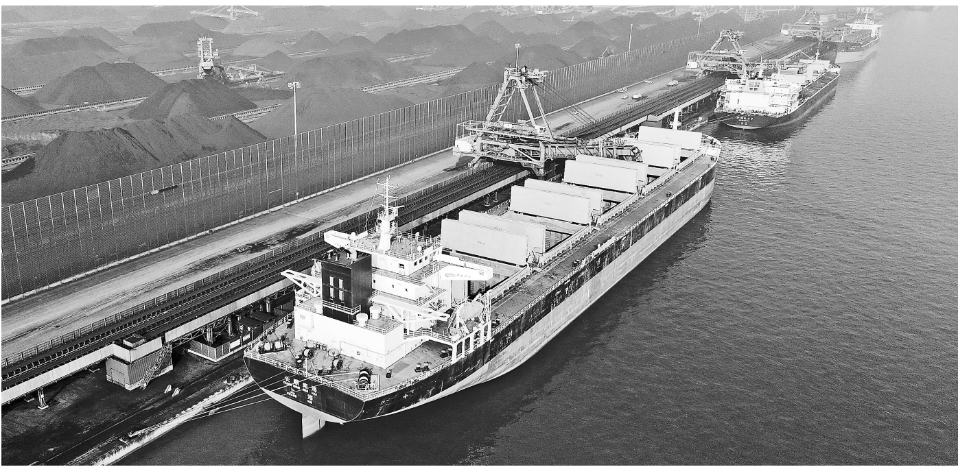
12月5日,多艘轮船靠泊在唐山港曹妃甸港区国投曹妃甸港口有限公司煤炭码头装货。近日,我国“北煤南运”的重要枢纽港河北省唐山港与海事部门联动,开辟电煤绿色通道,优先保障电煤运输船舶进出港,提高电煤卸载和转运速度,全力保障电煤运输。新华社发
