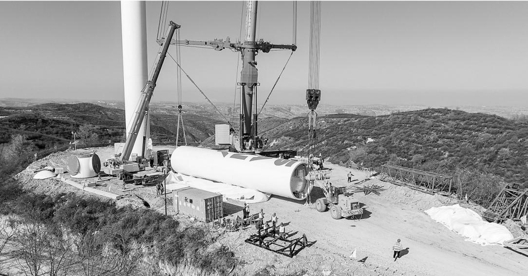
山区风电建设忙 近日,工人们在崇信县黄寨镇风电项目建筑工地组装风机底座基础、安装塔筒。
