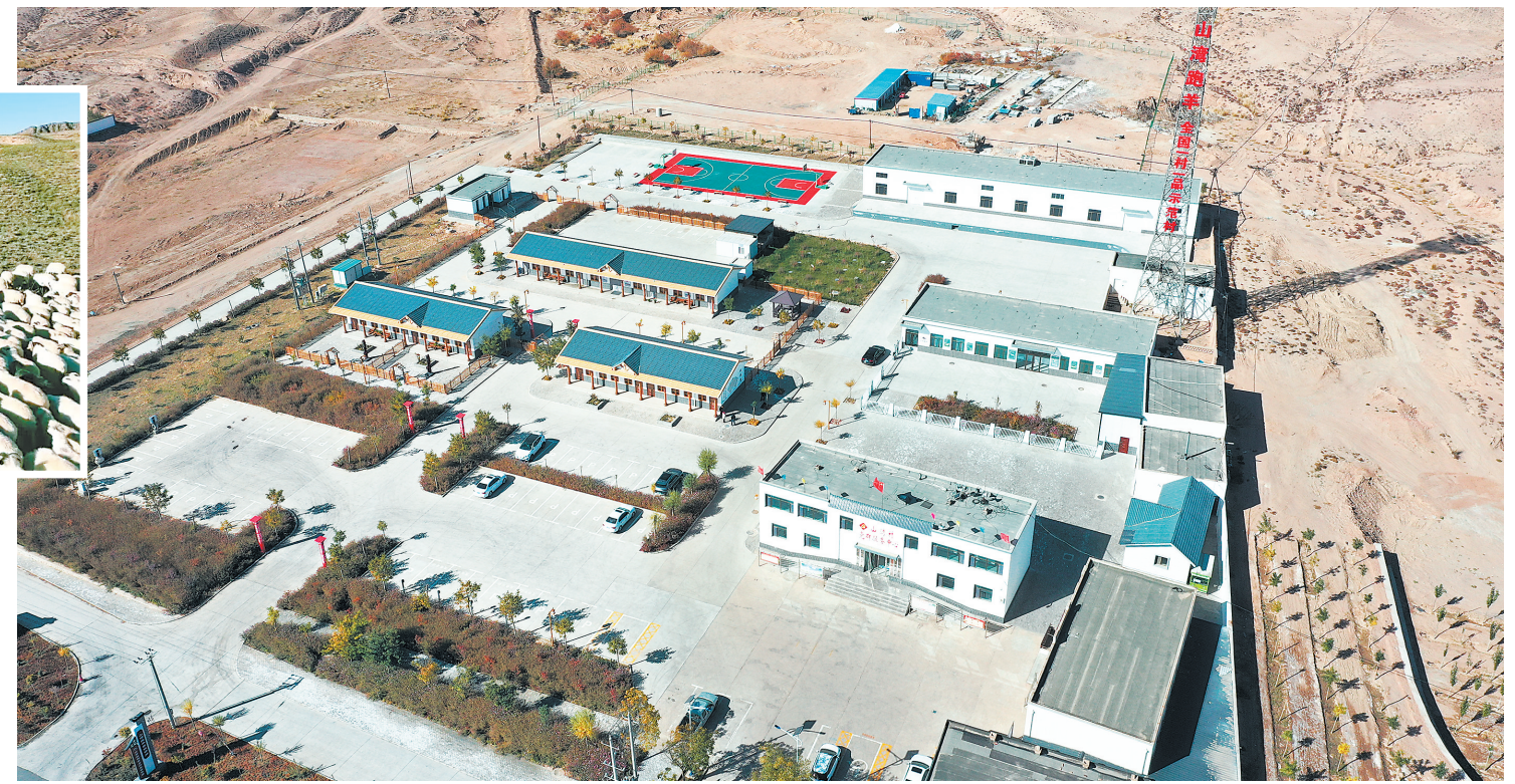
金川区宁远堡镇山湾跑羊乡村振兴产业园。 张良德
