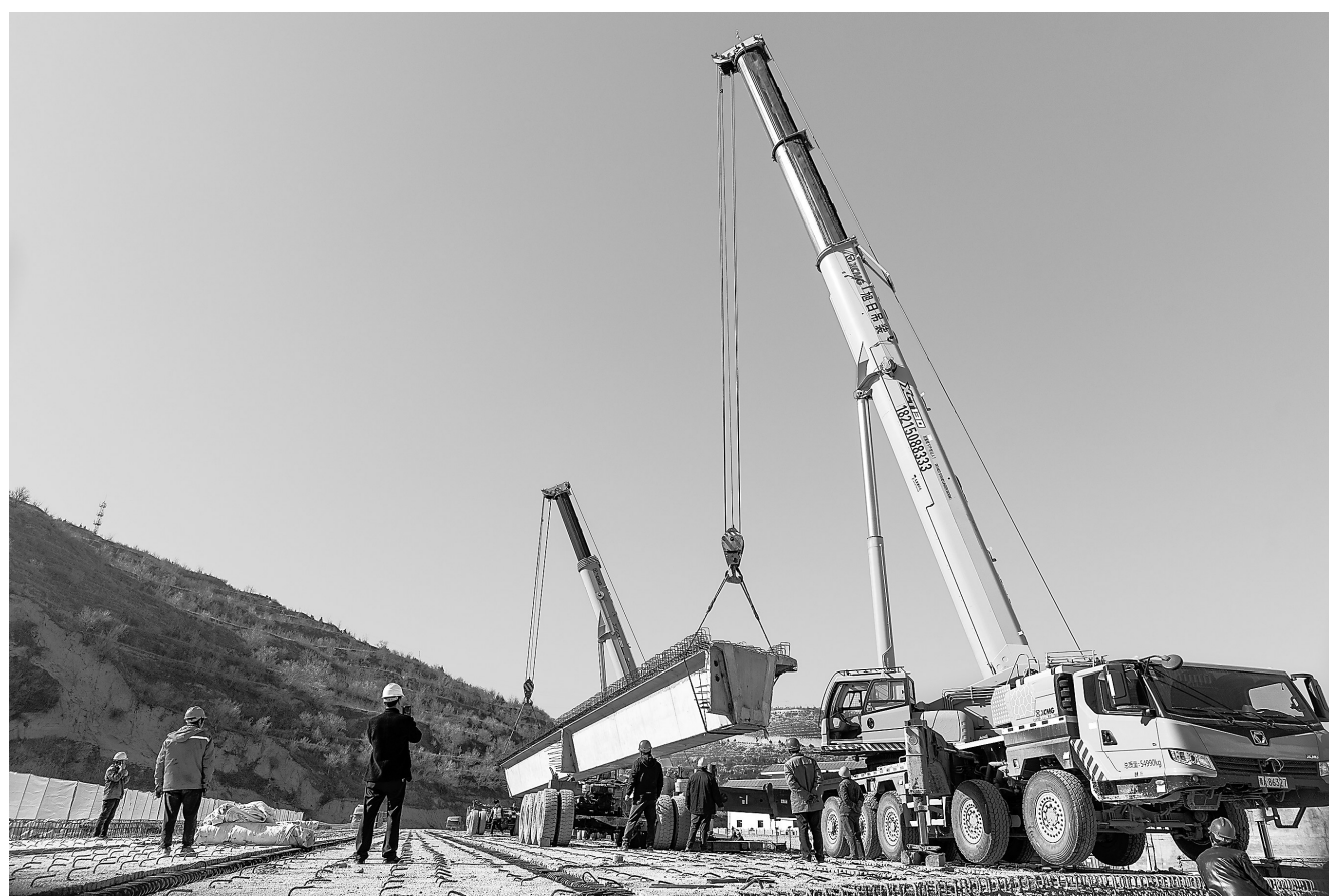
近日,通渭县牛谷河沿岸在建大桥完成箱梁架设施工。今年,通渭县实施“十大城建工程”项目34个、总投资50.1亿元,建设市政道路10.1公里,交通基础条件不断改善。
