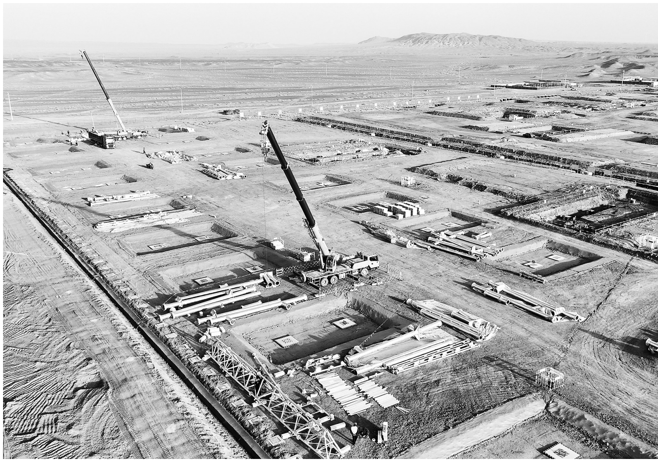
11月24日,金塔750千伏输电工程正在有序推进。
