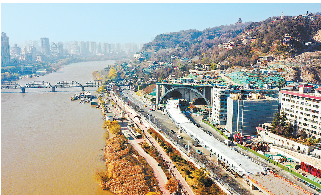
近日,白塔山隧道全线贯通,标志着黄河流域兰州白塔山段综合提升改造项目一期工程的重大节点目标完成。项目隧道工程西起龙源公园,东至靖远路,主线全长约2245米,建成后有效缓解该区域交通拥堵问题。新甘肃·甘肃日报记者 丁凯
