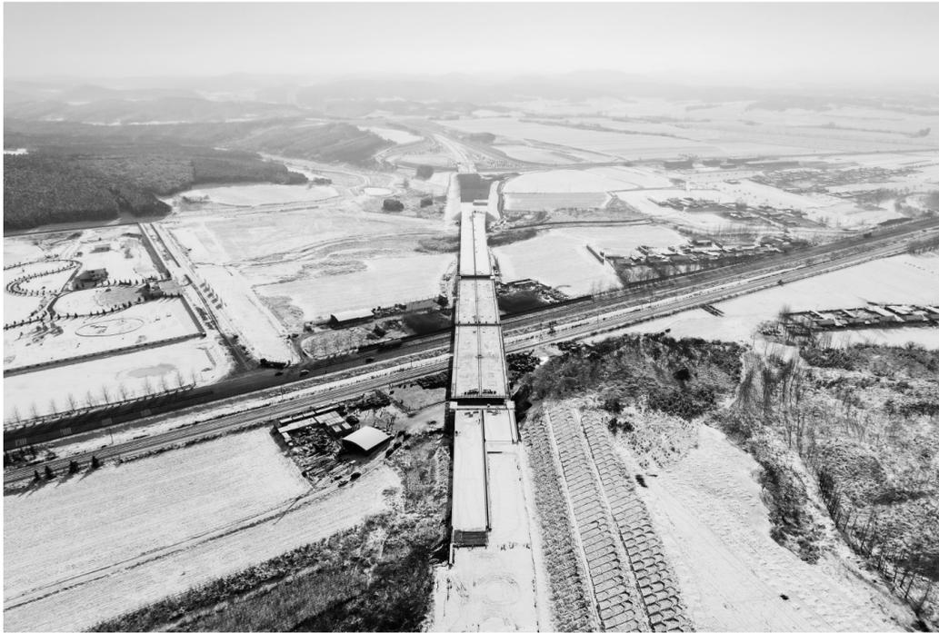
11月14日，长春经济圈环线高速公路转体桥(九台段)顺利完成转体施工。该桥是跨越长(春)图(们)铁路的首座转体桥。 新华社发
