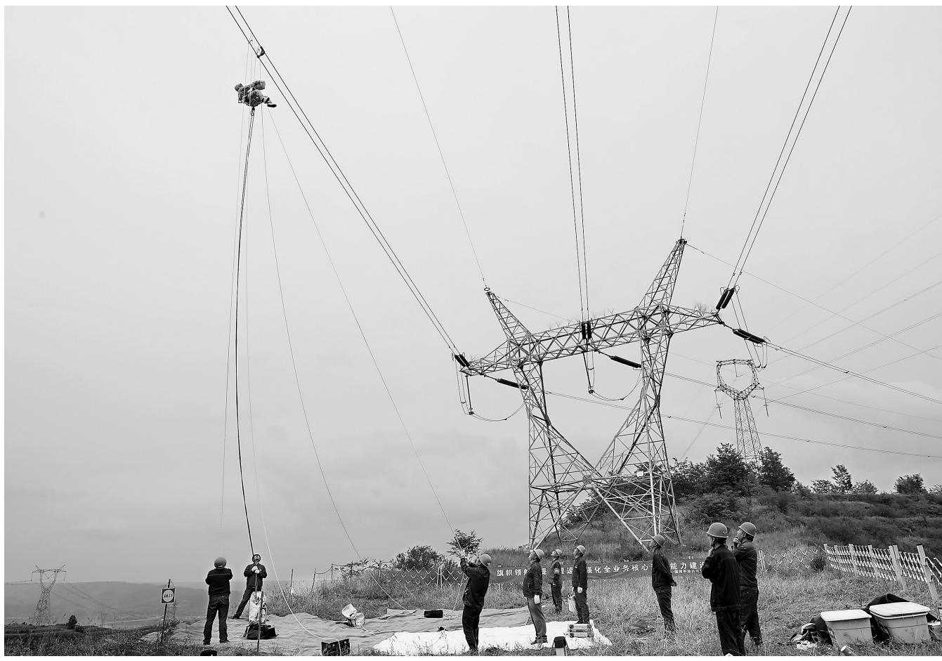
近日,国网平凉供电公司输电运检中心工作人员正在进行秋季检修,确保电网安全稳定运行。新甘肃·甘肃日报通讯员 王银燕
