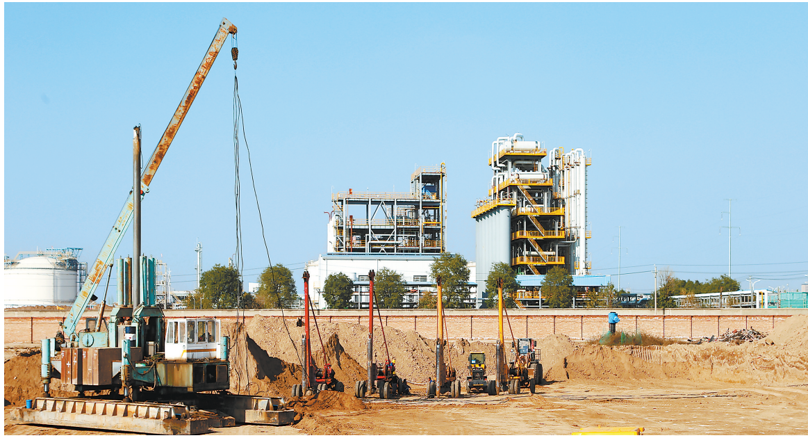
近日,庆阳市天然气提氢与储备调峰一体化项目加紧施工,各项工作进展顺利。 新甘肃·甘肃日报通讯员 盘小美
