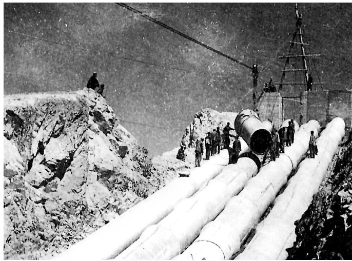
景电工程一期工程上水管安装现场(老照片)。
