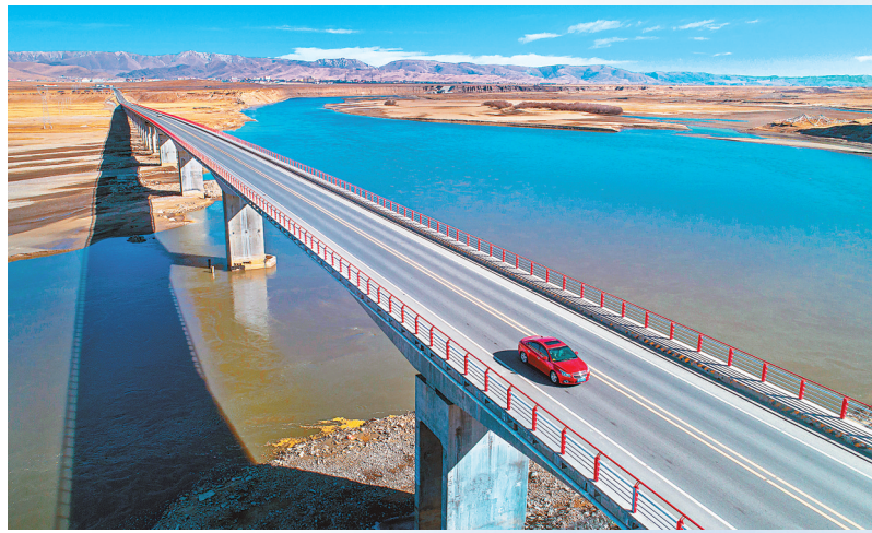
玛曲黄河特大桥 王晨旭
