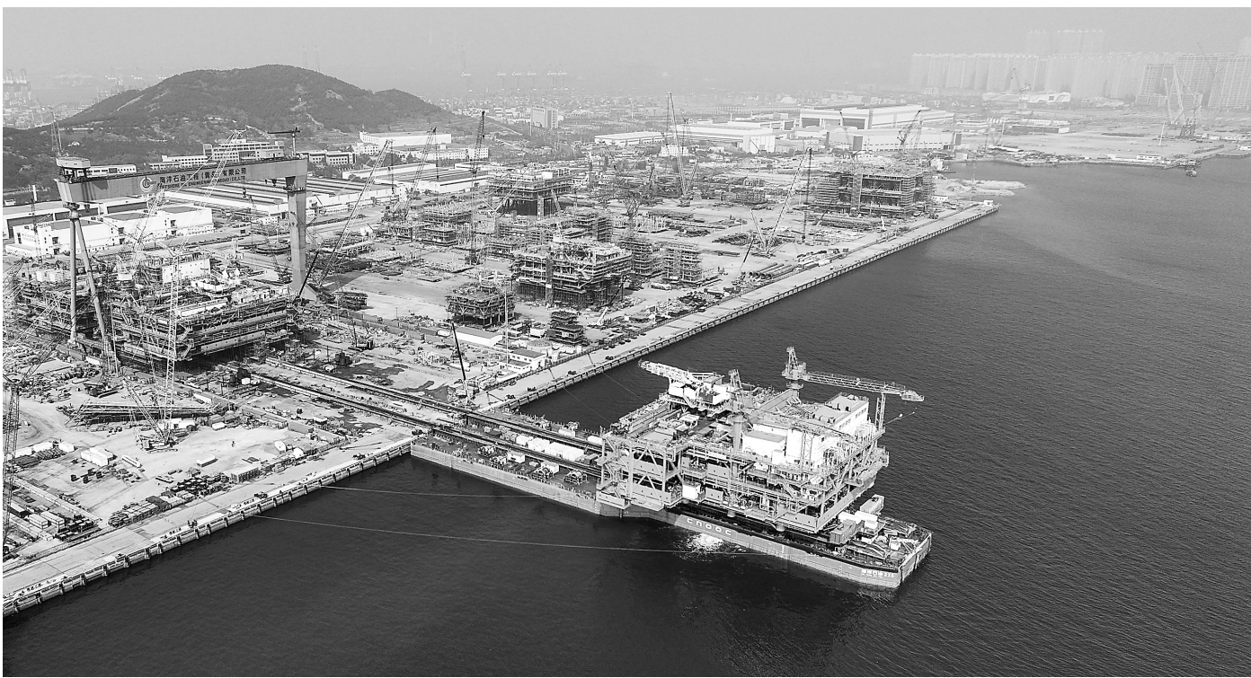
10月26日,理北油田中心平台在山东青岛完工装船,平台装船后将赴渤海西部海域,进入海上安装和调试阶段。这一油气处理与岸电设备共建平台总重量近15000吨,将高压输电设备与油气处理模块建在同一平台上,实现岸电的引入,这是该模式在国内的首次尝试。新华社发
