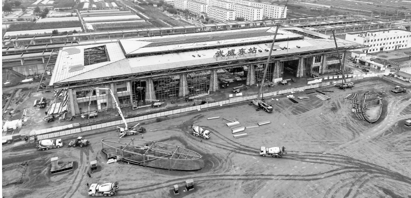
近日,由中铁建设承建的兰州至张掖三四线铁路兰武段武威东车站站房正在加紧建设。 新甘肃·甘肃日报通讯员 宋佳龙
