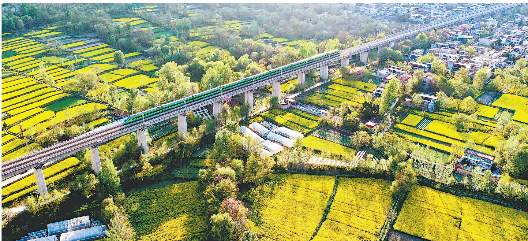
兰渝铁路宕昌县沙湾镇沙坝特大桥。
