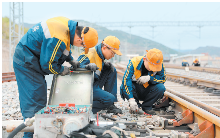
兰州电务段职工在兰渝铁路哈达铺站进行设备检修。新甘肃·甘肃日报通讯员 张卫忠
