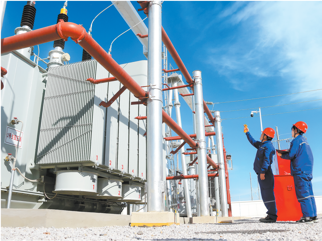
9月30日,工作人员在敦煌市北湖风电基地海棠红柳风电场110千伏升压站巡检设备运行情况。
