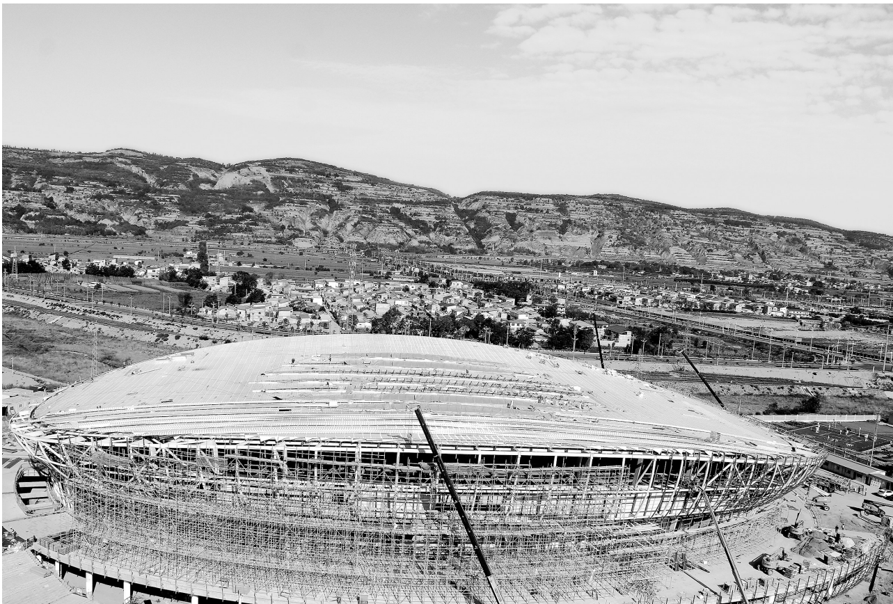
近日,在静宁县城关镇南关村体育馆施工现场,建设者们正在施工作业。目前,该项目主体结构已完成。新甘肃·甘肃日报通讯员 王毅
