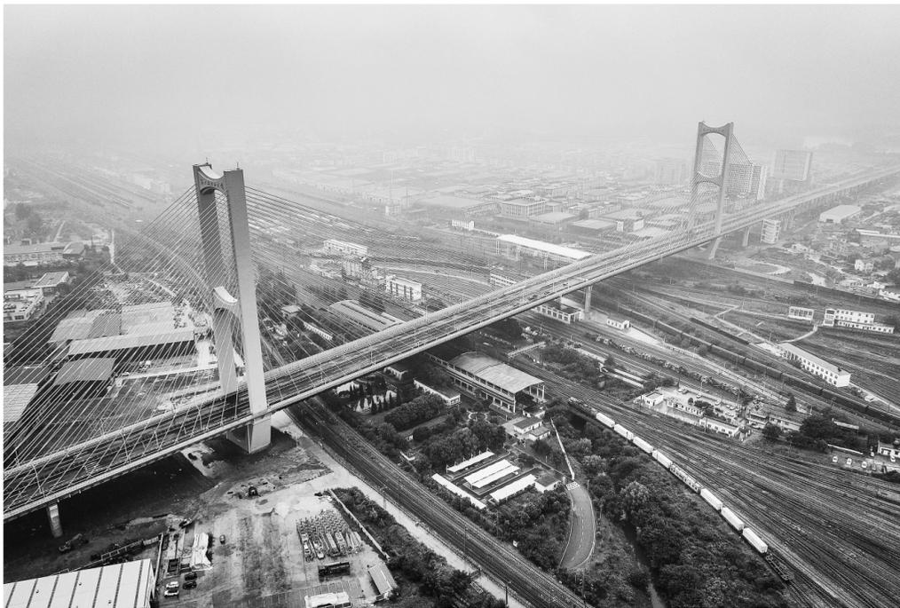
9月11日,湖北省襄阳市襄北编组站大桥正式通车。襄北编组站大桥由中铁十一局承建,大桥为双独塔双索面混合梁斜拉桥,主桥长920米,宽37.5米,其中跨越铁路站场部分总长度为520米,跨越铁路32个股道。
