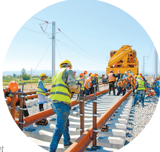
施工人员在古浪县泗水镇铁门村铺轨作业。
