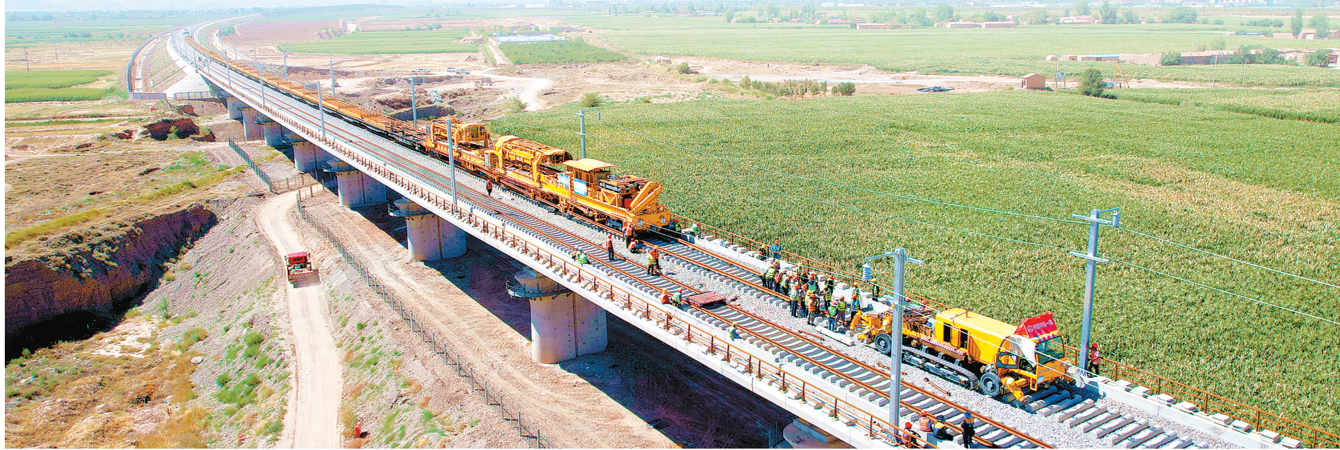
兰张三四线铁路兰武段铺轨工程全面推进。 本文摄影:新甘肃·甘肃日报记者金奉乾
