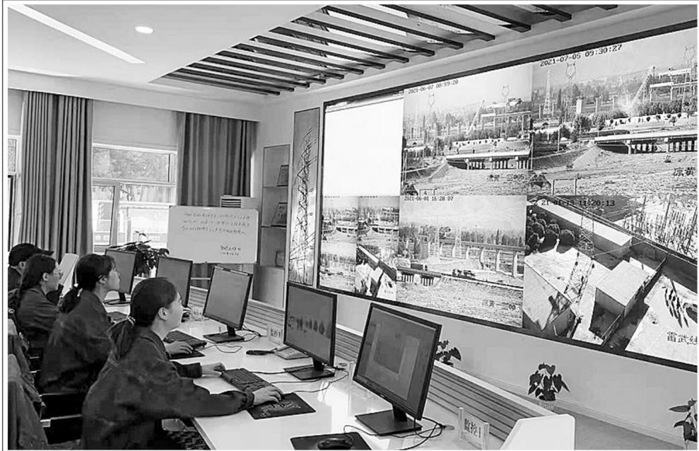
近年来,国网武威供电公司积极打造全景智慧物联管控中心,这是智慧巡视、智慧应急、智慧检修的智能运检管控平台,可实现在线监测实时监控、无人机巡检、人巡移动终端作业管理,达到生产指挥、故障预警、应急保障等人员设备集约化管理的目的。宗殿杰 李晓嘉 摄
