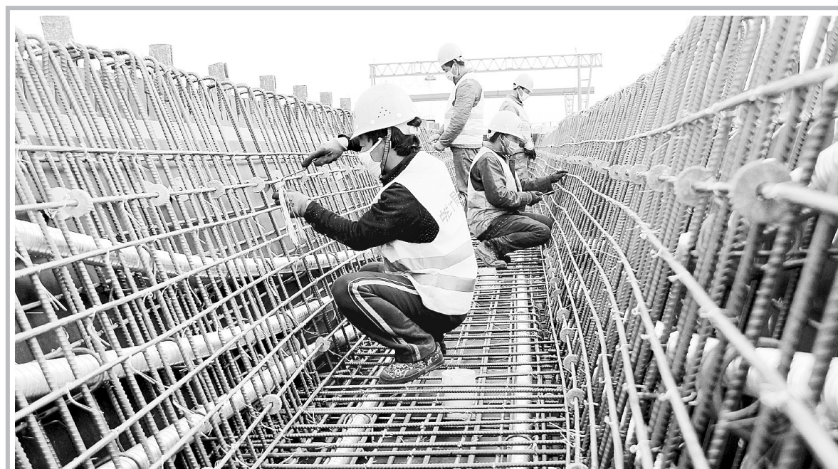
为把疫情耽误的“春光”抢回来,中铁二十局贯彻落实甘肃省委、省政府和项目业主关于防疫管控的各项要求,挂起作战图,标明攻坚点,细化时间表、任务书,确保在建项目“能复则复、应复尽复”,实现经营、产值两大指标逆势上扬,经营承揽、施工产值较去年同期分别增长100.7%、9.9%。图为该局市政公司参建员工在甘肃省重点工程——张扁高速公路桥梁作业现场绑扎钢筋,为全线年底达到通车条件夯实基础。 许岗摄
