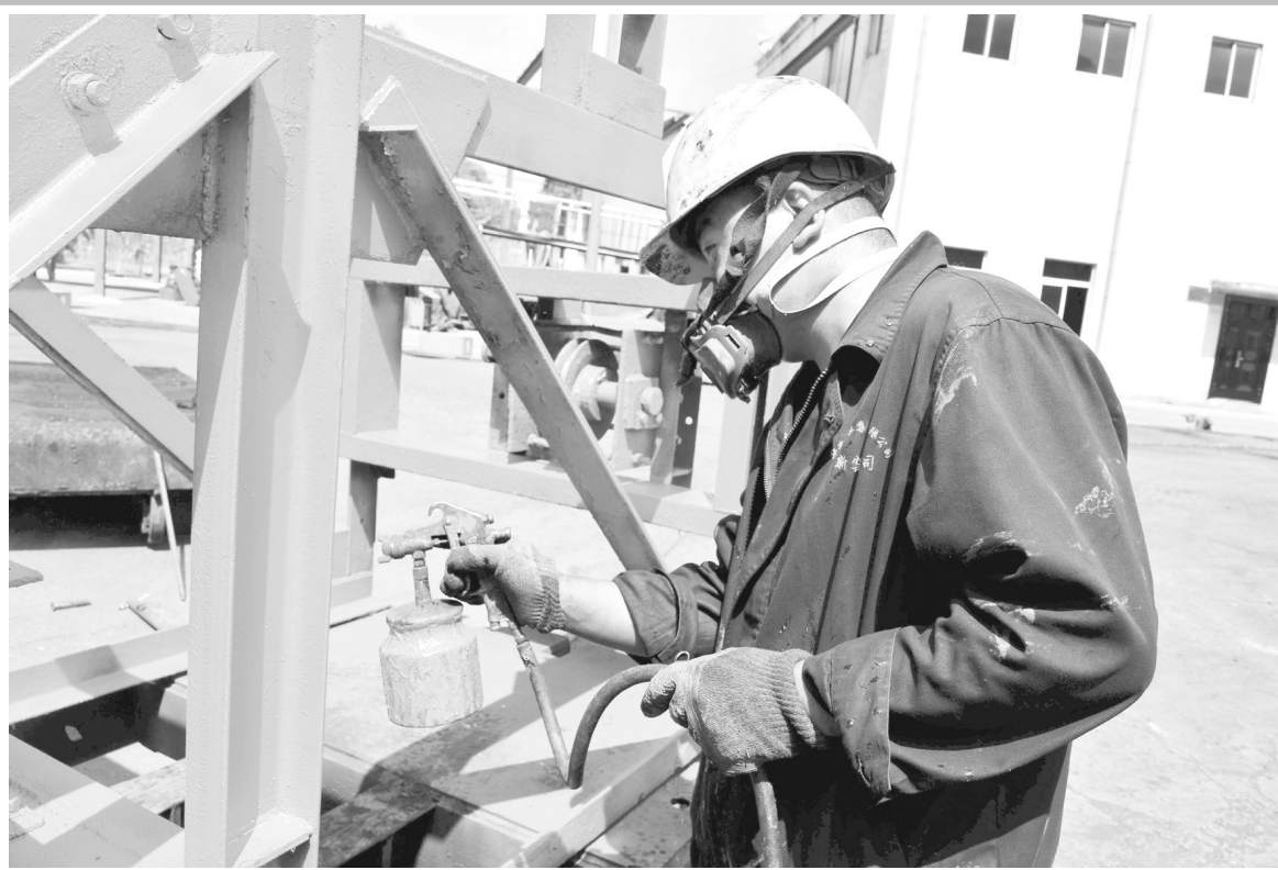
连日来,华亭煤业集团公司东峡煤矿广大干部职工奋战在37221-1工作面安装、37121-1工作面回撤和选煤楼螺旋筛更换、升级现场,为完成全年目标任务而奋斗。图为综掘队电钳工黄琪顶着烈日正在给检修好的设备喷漆。 白银宝 摄
