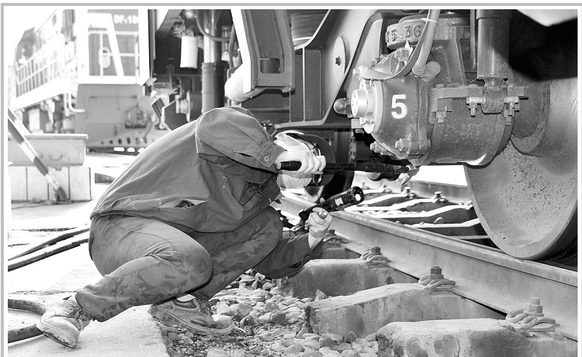
兰铁兰州车辆段认真抓实疫情防控,抓细复工复产,抓严安全生产,确保“两不误、两促进”,严格卡控客车大修质量,为每一列出库上线的动车组提供安全保障。图为该段职工在检查Z55次组中车辆轴箱装置。 吴剑 摄
