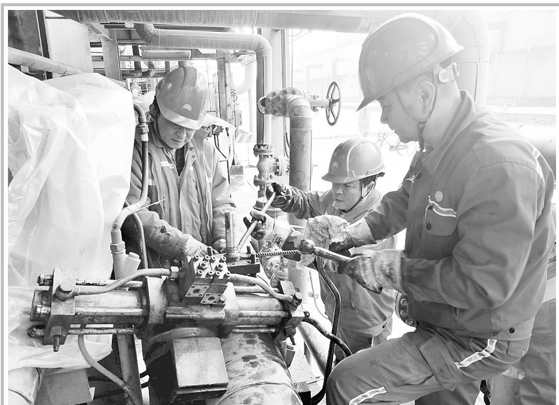
为深入推进“绿色企业”创建工作,中国石油兰州石化公司通过狠抓标准化操作,推进现场管理由“末端治理”向“源头控制”转变。图为该企业二级单位的维达公司员工正在保养化肥厂苯胺生产装置的传动设备。曹平 摄
