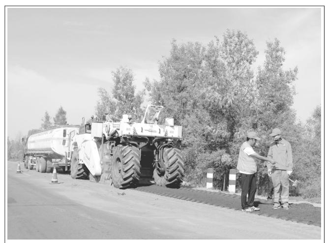
近年来,酒泉公路局金塔公路段不断加大技术创新力度,推广运用多项新技术,2019年已经是该段第三年采用就地冷再生技术对管养干线公路进行养护维修,截至目前,累计实施2.45万平方米,后期效果良好,成效显著,提升了科学养护和服务质量水平。图为拌和铣刨机在现场施工。闫文辉 摄
