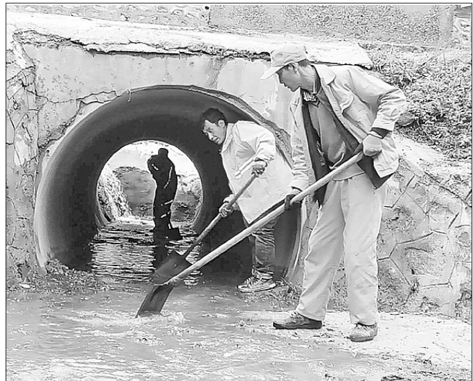
为进一步做好汛期公路安全保畅工作,武山公路段根据季节气候变化特点,积极动员部署,切实把汛期公路养护工作落到实处,全面夯实防汛基础确保辖区内公路安全畅通。图为职工清理排水沟时的情景。刘志伟 摄
