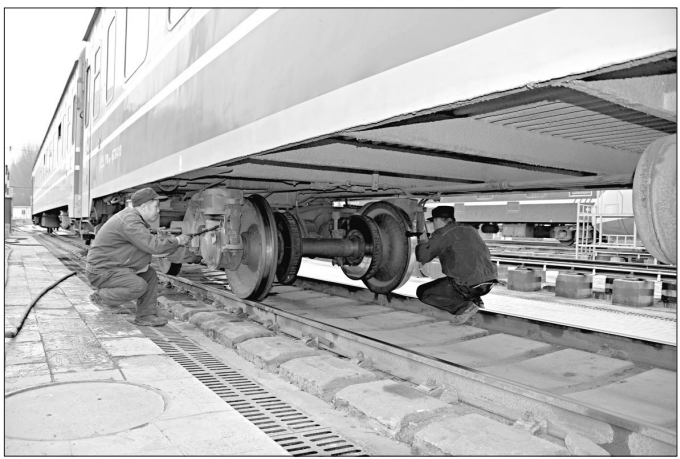
为确保新列车运行顺利实施,兰铁兰州车辆段以再紧一扣、再严一格的要求,加强检修盯控,严格作业标准,强化关键管控,对安全管理、检修质量进行全面督查,将安全隐患消除在出库前。图为该段职工对T6601次车辆平行检查作业。 吴剑 摄
