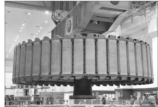
近日,随着重达700多吨的发电机转子成功回装,标志着刘家峡水电厂3号发电机组A级检修及定子改造工作已进入全面回装阶段。此次改造将根本性解决3号机定子绝缘胶老化、铁芯老化、松动、过热等“顽疾”,更好发挥发电效益。侯齐 摄
