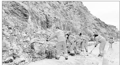
近日,张掖境内连续出现降雨天气,造成临泽公路段管养的S213线个别路段山体塌方。该段加强值班值守,加大雨天道路巡查频次,迅速组织人员对塌方路段的积石进行清理,确保了道路安全通行。图为该段职工清理S213线K52+900处山体塌方情景。王海龙 摄
