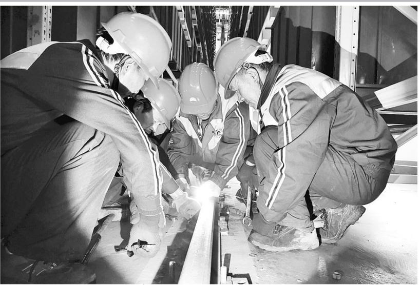
丁苯立体库是今年五月份兰州石化化工储运厂检修重点项目。通过计划检修、设备中检、隐患排查等方法,即查即修,循序渐进,使短板和薄弱环节得以彻底整改,使设备达到良好运行状态。图为检修人员精确计算衡量堆垛机地轨。贾继军 郭彦彦 摄
