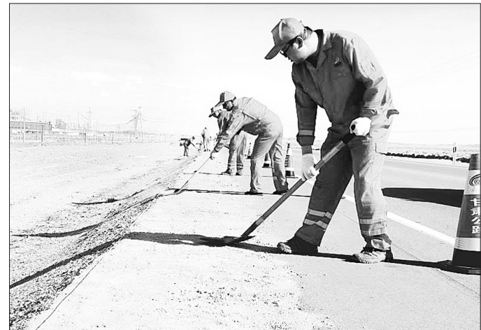
日前,酒泉公路局马鬃山公路段举办养护技术比武活动,重点对公路沿线标识标牌、路容路貌、路基边坡垃圾杂物进行清理整理,全力以赴保障2019年中国绿公司年会在敦煌顺利召开。冯磊 摄
