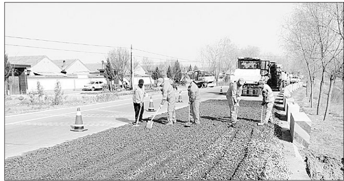
近日,镇原公路段利用晴好天气开展路面坑槽修补和路面灌缝工作,积极营造畅、安、舒、美的公路通行环境。图为路面修补现场。 王若尘 贾建苗 摄
