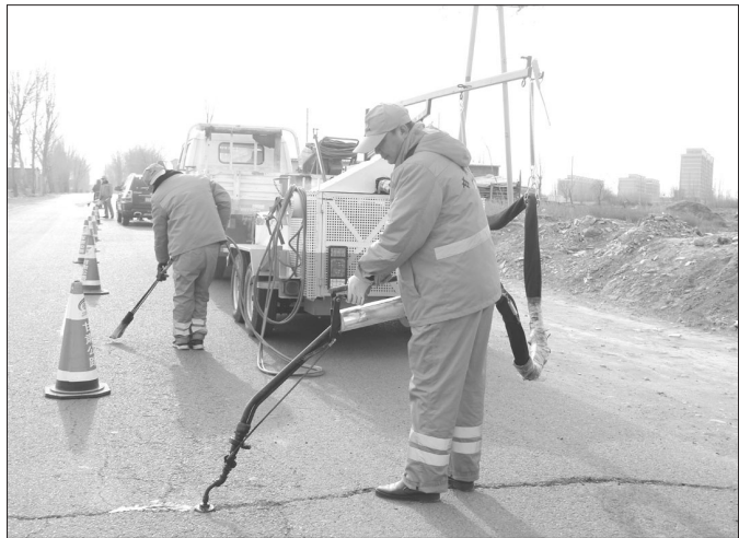
为全面扎实做好2019年养护工作,甘州公路管理段对所管养的各条公路路况进行全面病害处理,保证公路养护的科学性,为平安公路建设再创佳绩。图为路面灌缝作业。 于雷 唐俊 摄
