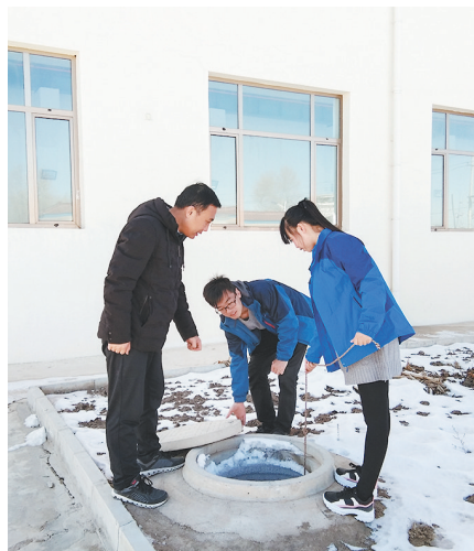
王海军和杨俊花检查供水设施
