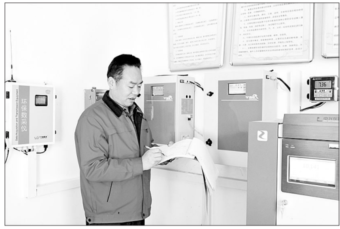
康县污水处理厂认真做好污水处理的每一道工序,对各项数据都认真进行检查登记。图为工人在出口站房巡查登记COD、氨氮数据,确保数据达标后排放。马步虎 摄
