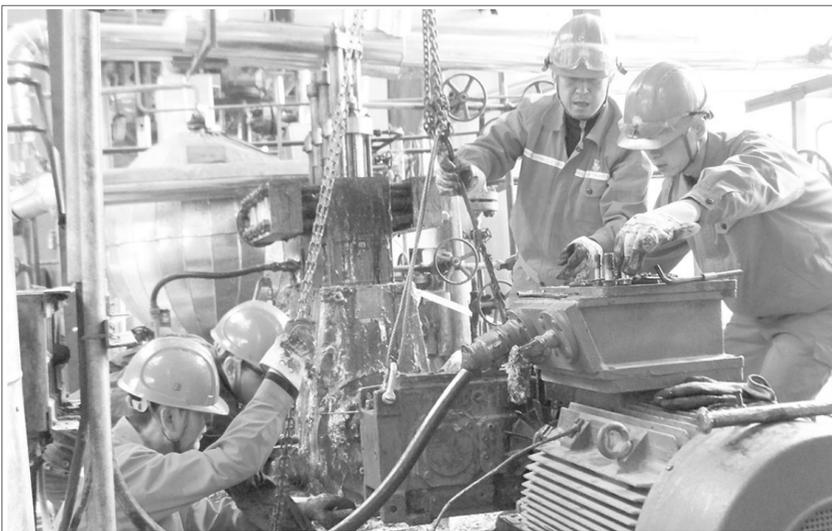
近期,兰州的气温持续走低,中石油兰州石化维达公司员工不惧严寒,加班加点检修石化树脂装置的传动设备,努力为兰州石化公司完成全年生产目标提供高效、优质的服务与保障。图为该公司员工现场检修高速泵。
