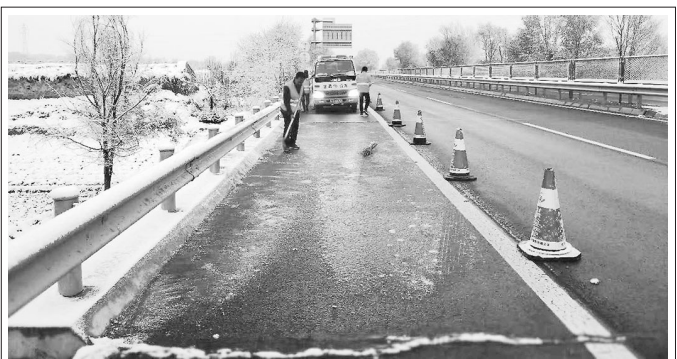
11月3日夜间到4日晨,定西境内迎来了今冬首场降雪,甘肃成远路业(集团)有限公司“以雪为令”立即启动防滑保畅预案,各工区、各部室人员迅速到防滑保畅现场,完成了保畅任务。图为职工在清扫积雪。刘慧毅 江虹俐 摄
