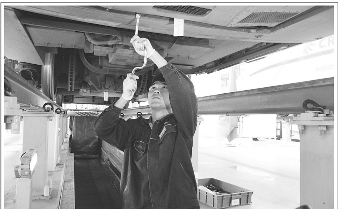
近日,兰铁兰州车辆段动车所从制动动车组检修方案、提高设施设备质量入手,加大动车组检修力度,细化严控质量措施,积极备战冬运,不断提高动车组安全性能。图为该段动车机械师在进行动车牵引电机轴承注油作业。吴剑 摄
